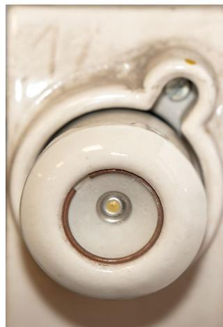
**Bild 2 – Beispiel für eine intakte Glasscheibe an der Schraubkappe**
